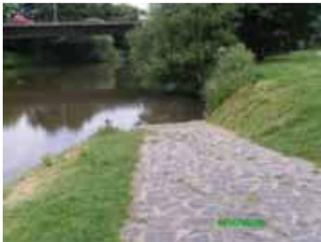
Abbildung 9: Gießen 2. Wehr, Zugang zur Einsetzstelle, baulicher Zustand
